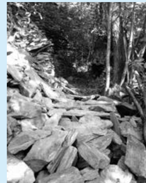
Lavori a Capoloira
